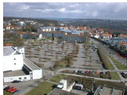
Abb. 1: Das Gelände vor Baubeginn.
